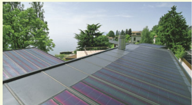
PV-Anlage mit Dünnschichtzellen aus amorphem Silizium. (Frédéric Pachoud)
