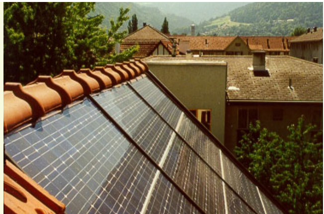
Gelungene Dachsanierung mit Solaranlage. (Raimund Hächler)
