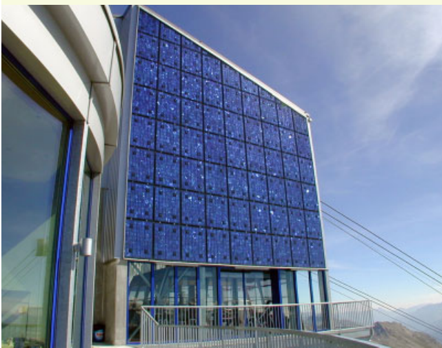
In Fassade integrierte PV-Anlage mit mikrokristallinen Solarzellen. (NET AG)
