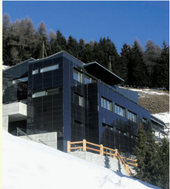
Optimal ins Gebäude integriert: Die Solarstromanlage bildet die Fassade eines Privathauses. (Josef Troxler)
