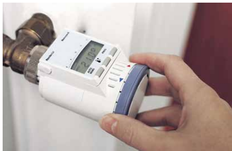
Es lohnt sich, am Thermostat zu drehen: Jedes Grad Temperaturabsenkung spart bis zu sechs Prozent Heizkosten.
