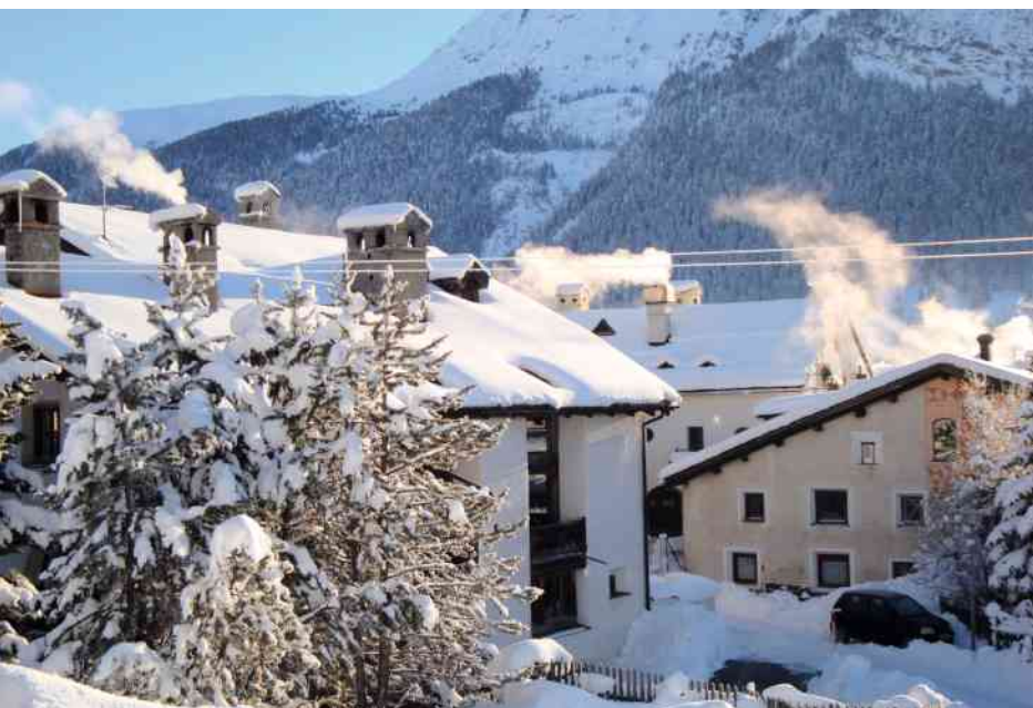
Viele Zweitwohnungen werden in unbewohntem Zustand auf 20 Grad und mehr beheizt, zum Teil aus falschen Vorstellungen heraus. Im Bild Mehrfamilienhäuser in La Punt, Oberengadin. (Foto: Stefan Hartmann)
